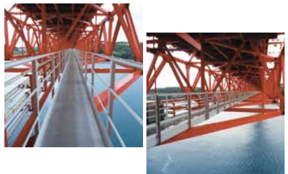
写真8, 9 平戸大橋へのアルミ合金製検査路設置状況
