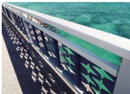
写真2 設置後31年経過したアルミ合金製高欄
