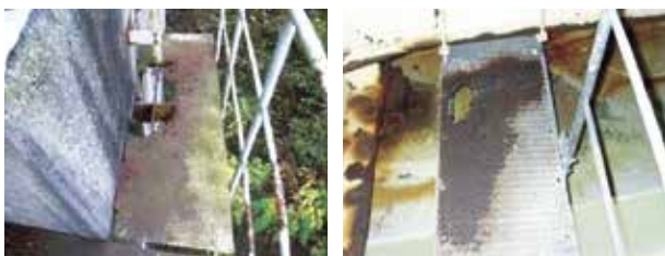
写真1 下部構造検査路の腐食 写真2 上部構造検査路の腐食
