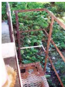
写真1 鋼製検査路の腐食状況
