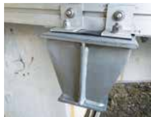
写真3 既設アルミニウム合金製検査路 写真4 異種金属接触腐食対策の一例
