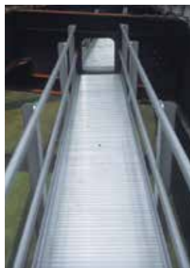
写真4 点検者の安全性に配慮した歩廊面、手摺
