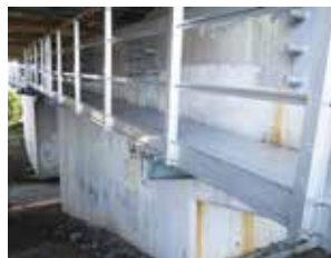
写真3 既設アルミニウム合金製検査路 写真4 異種金属接触腐食対策の一例
