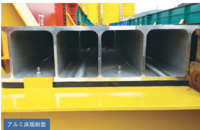
アルミ床版設置状況
