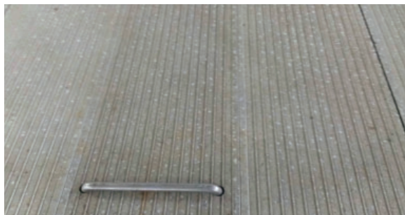
【写真2】 最初沈殿池 覆蓋本体の外面の代表的な外観
