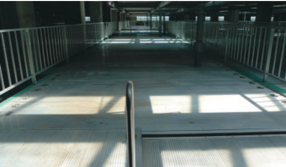
【写真 6】 全景（手前はエアレーションタンク部可動蓋の箇所）
