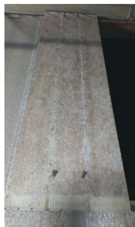
【写真3】 最初沈殿池覆蓋本体の内面（処理槽側）の代表的な外観
