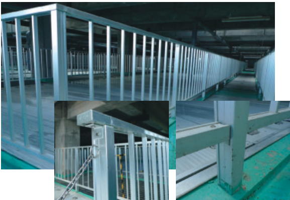
【写真 9】 転落防止柵（全景・チェーン取り付け部・定着部）
