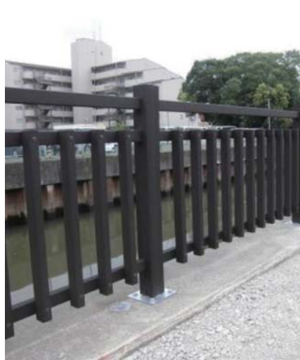
伝右川環境整備工事(埼玉県)
