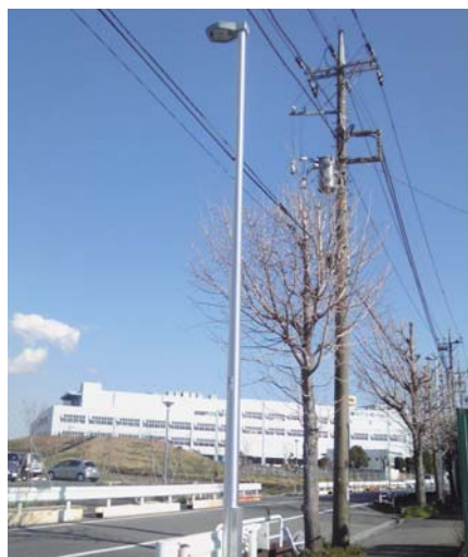
照明ボール(神奈川県)
