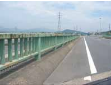
取替前の状況
