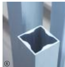
H形の梁(高さ250mm、右上)と骨組となる柱(100mm角、右下)は、いずれもアルミ押出型材で、隙間なく接合されている。
