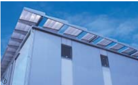
本体屋根の上は、太陽電池パネル、アルミバンチングメタル、アクリルトップライトを組合せたダブルスキン構造となっている。
