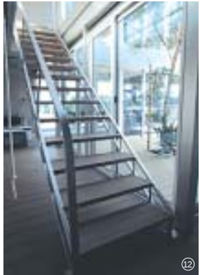
階段は軽快なアルミトラス構造で、踏板は木方の再生材でできている。
