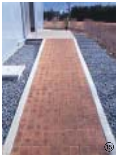
アルミドロスによる敷石。アルミニウム以外の材料もできるだけ環境負荷の小さいものを使用。
