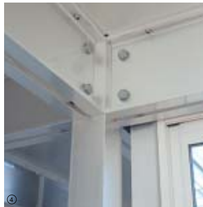
H形の梁(高さ250mm、右上)と骨組となる柱(100mm角、右下)は、いずれもアルミ押出型材で、隙間なく接合されている。
