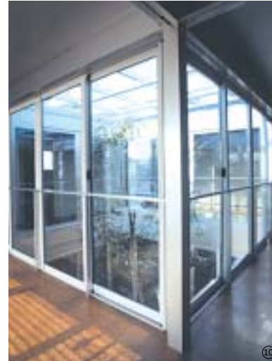
2階の中庭側はすべて開口部で、採光は十分。プラスチックとアルミの複合サッシを使用している。
