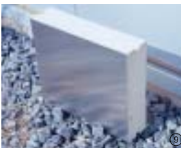
本体屋根、外壁は発泡ウレタンをアルミパネルで挟んだ構造。
