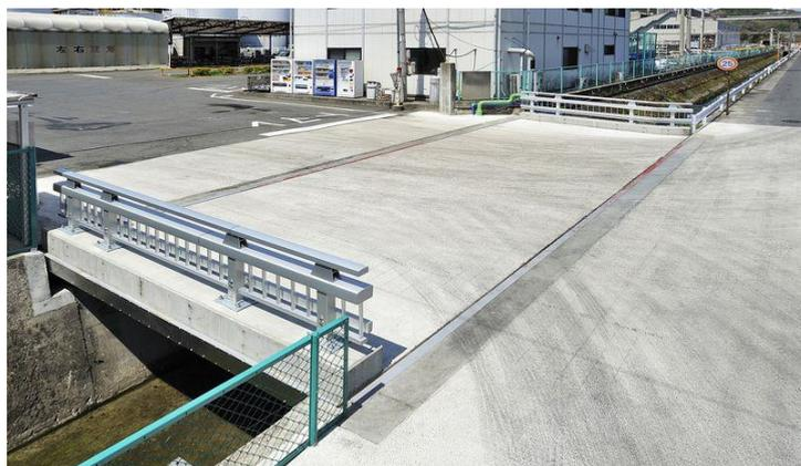
図 1.4 道路橋用アルミニウム床版を用いた鋼桁橋
