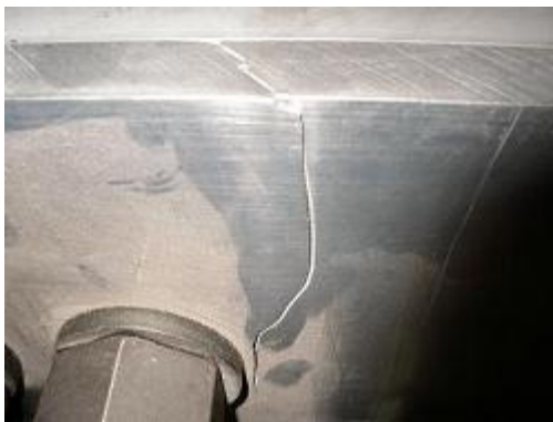
図 17 下フランジの添接板に発生した疲労亀裂
