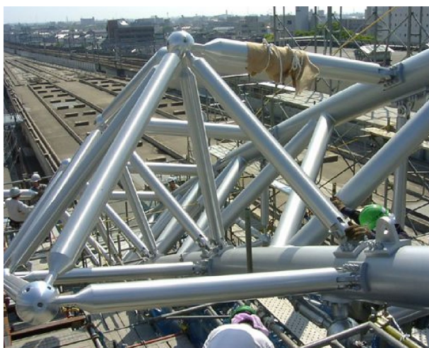
アルミトラス施工時
