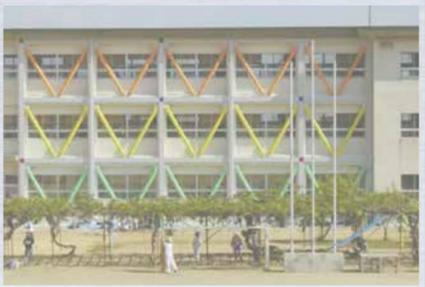
アルミ部材を用い、建築物の耐震補強を行ないます。平成7年の阪神淡路大地震の経験を活かす、耐震改修促進法が施行され、その補強方法の一つです。鶴ヶ丘小学校では、海岸から300mの距離にあるため腐食の問題回避には工場製作の規格品による短工期が認められたのもです。通常の補強方法では、建築物が暗くなるのも、アルミに塗装を施すことでもむる以前よりも明るく仕上げる事が出来ました。
