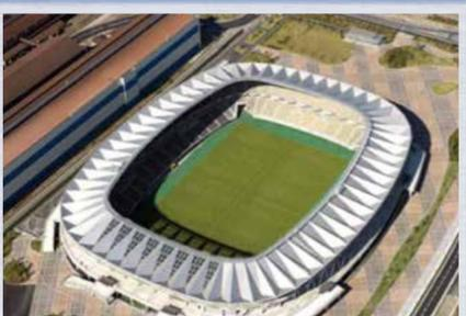
客席数約18,500人のサッカー専用競技場です。建物面積約16,000㎡、階数地上4階建て、建築高さ約25m、スタンドの約90%を覆う屋根に接着アルミハニカムパネルが採用され、その面積は13,800㎡で建築に採用された面積として国内最大級です。
