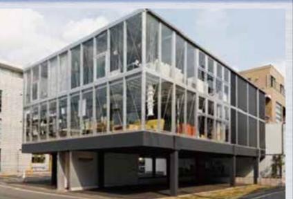
フィルパークは時間貸駐車場上部に立体空間を構築し不動産として賃貸するという事業です。構造体にアルミフレームを用いたのは、軽量でボルトナット接合による機械的構造はアルミ構造体の特徴であり、建築物の短期施工性や不要時の解体・移設が可能になり、リユースの実現性も高まります。工場でボックス状にアルミフレームを組立てトラックで運搬、現地で建設業者が連結する為、施工時間の大幅な短縮が可能となります。
