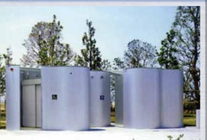
1種類の湾曲したアルミ押出形材が垂直・水平力を負担する自立壁となり、基礎にボルト接合されています。ガラス屋根は合わせガラスに太陽光発電セルを封入しています。明るく、風通しがよく、清潔感がありメンテナンス性の高い、入りやすいトイレです。
