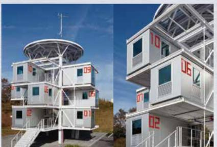
実験棟は4層建ての鉄骨構造体(スケルトン)にインフィルとしての12個のt2ユニットを挿入しています。アルミと異素材の共存であり、今後、鉄骨の構造体も組み立て式とし、システムとして供給できるようにします。ユニットの増減は自由で最多24まで増やす事が出来ます。
