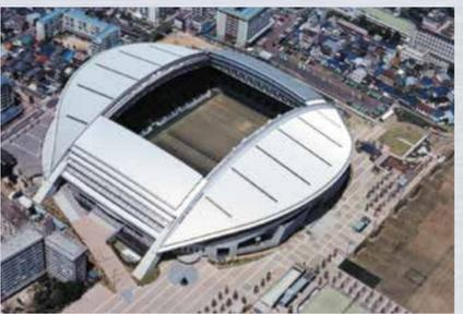
アルミニウム折半閉鎖式ドーム屋根を備えたスポーツコミュニティの拠点として建設。ウイングスタジアムの局面屋根にはライフサイクルコストの低減、周辺環境への配慮の観点からアルミニウム屋根が用いられました。耐久性が高く、低光沢処理材が採用された結果、維持管理費の低減、周辺の光・音環境への配慮が達成されており、アルミニウムの特徴を生かした先進的な開発技術が結集されています。
