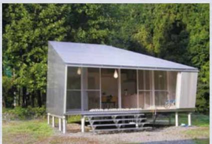
アルミニウム合金造の建築構造材としての適用可能性を検証するための実験棟として建設されました。耐食性が良い、軽くて強い、表面が美しい、押し出しによる自由度や寸法精度の高さ等、アルミニウムの特徴を活かせる山間部や海浜地のメンテナンスフリーのコテージを対象物件としました。
