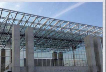
体育館のエントランスにアルミボールジョイントトラスが採用され、屋根はアルミ押出形材の枠とガラスで構成されています。
