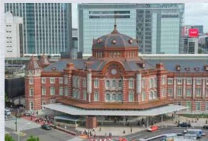
東京駅丸の内駅舎保存・復原工事に伴い、南北ドームのエントランス大庇(2か所/約700㎡)に鉄骨及び下地組を最小限に配置し、屋根材としてアルミハニカムパネルの特徴(高剛性、優れた平坦度を生かして施工工程の短縮化等)を活かして採用されています。また駅舎周辺には、サブエントランス、中央口ボード、ホテルエントランス、東京駅線路側庇と大小さまざまなアルミハニカムパネルが特徴を生かして設置されています。
