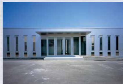
アルミニウム構造材が一般認定を取得してから最初の確認申請物件として社員厚生施設として建設したものです。アルミ造平屋で延べ床面積214.94㎡。基礎部を除いた構造部材、内装仕上げ部材、家具、備品類の殆どにアルミニウムを使用しています。十字の押出形材の柱とダブルウェブH型の押出形材の梁によるラーメン構造に、アルミ押出パネルの外壁です。
