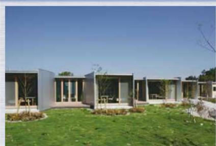
アルミの曲面壁は、2種類のR形状の押出形材で構成され、垂直力、水平力を負担しています。屋根材は、壁に載せるだけの屋根骨組みの納まりです。外観、内観ともアルミニウムのテクスチャーが美しく映えています。
