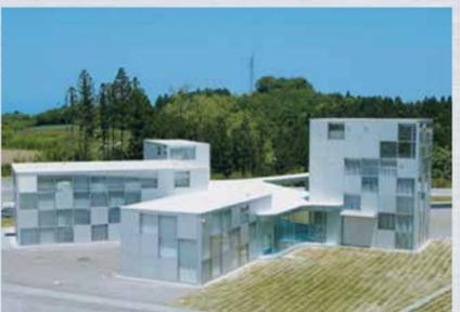
アルミ押出形材のユニットを嵌合して作られたラッシュバルによって、それぞれ異なる高さ、階数、平面形状を持つ4つのエコムハウスです。それら間にあるホワイエは不定形の形をしているので、柱による輪框構造です。
