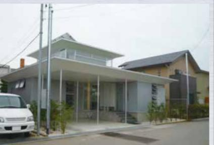
この住宅は構造体として、一つのアルミ基本材形によって4面リング状に組み上げ、柱、梁、スラブを構成する変形のデッキプレート型を使用し、アルミハウスの基本構造としています。アルミの素材特性と構造体の形状を利用して「構造体+放射冷暖房装置」として機能させ、構造体にユニットバス・キッチンといった機能を付加した多機能ユニットとして成立させています。
