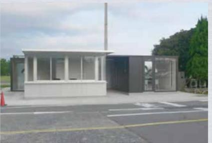
建物は、艶消しシルバーの守衛棟、ロッカー棟、ケミカルプラスト・ブラックの待ち合わせ棟、待機棟の4棟で構成されています。材料、加工、接合方法は改正建築基準法に適合しています。外壁とサッシにはフッ素樹脂配合複合皮膜、ケミカルプラスト処理、屋根の防水材にはアルミ箔をラミネートした防水シートが施工されています。2009年のグッドデザイン賞の大賞を獲得しました。
