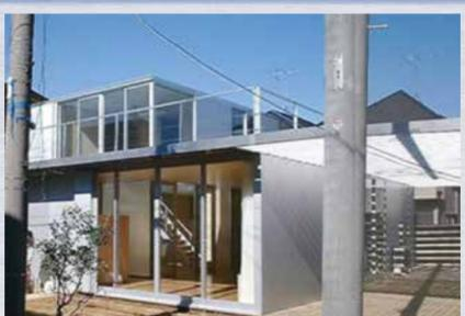
70mmの柱はサッシと一体化されアルミの押出形材がそのまま耐力壁になったシンプルで軽快な住空間です。十字の形材と座屈を防ぐバー材による「アンボン」柱とH型押出形材の梁に、アルミ押出プレートの壁パネルとアルミリブプレートの屋根、2階床という構成です。
