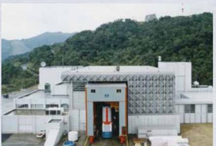
底辺1900mm×1900mm角、頂点の高さ640mmのピラミッド形の砂型アルミ鋳物のアルキャストを用いて階高約12mの中間支柱がない構造壁を実現しました。壁面は283個の単一ユニット、41本のスチール角パイプ、ガゼットプレートその他接合部品で構成されています。
