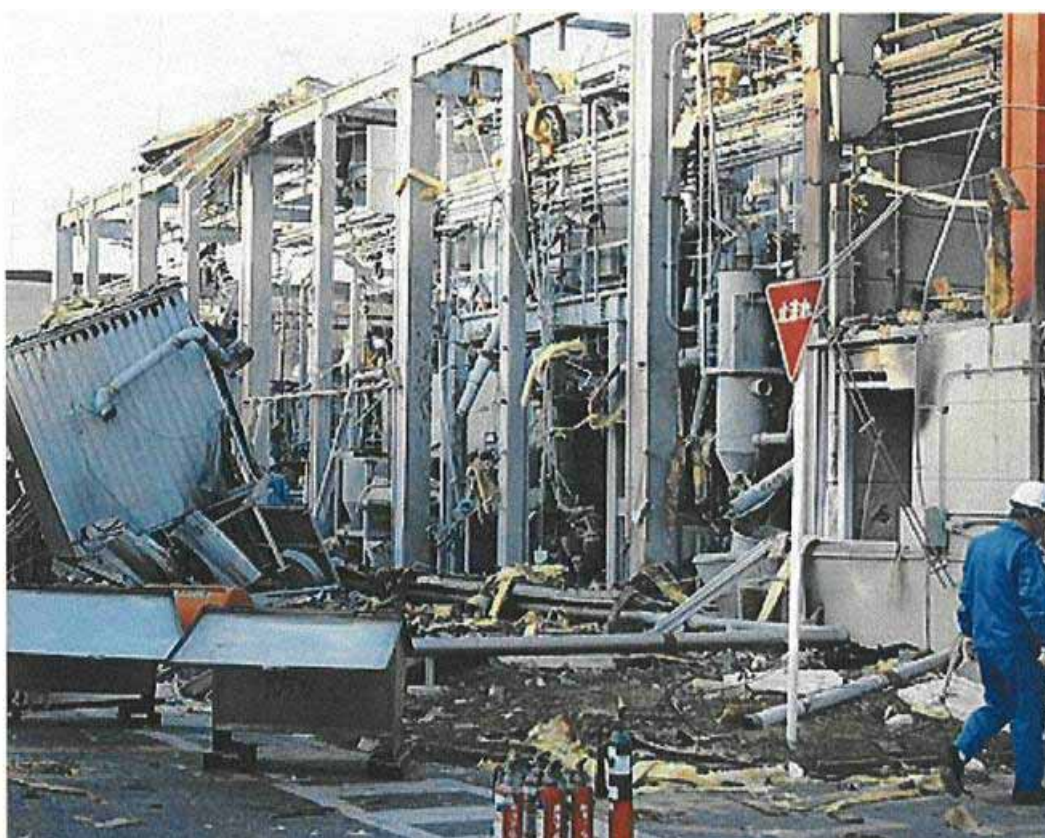
写真 2.1-2 粉塵爆発現場
