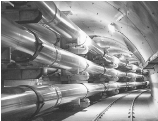
図1 長距離大容量送電用の管路気中送電線に使われているアルミ大型押出管（導体とシース）
