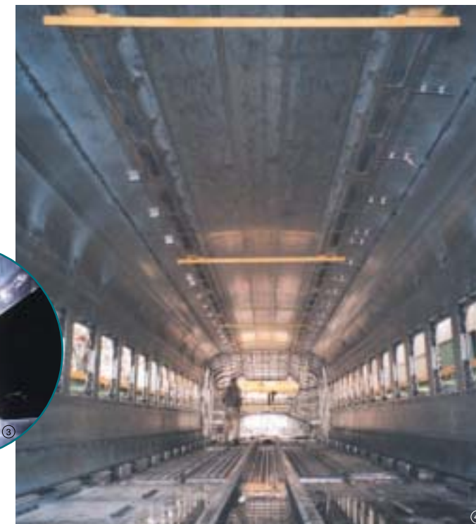
車体はアルミ中空型材を使用したダブルスキン構造で、曲げ剛性に強く、従来あった柱はない。アルミ中空型材は、制振材を中空部に充填したタイプと、制振材をリブ面に貼り付けたタイプが使われている(写真は先頭車の内部)
