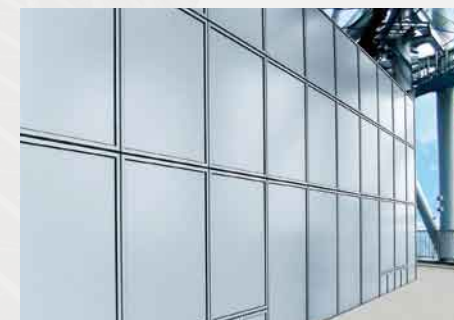
(上) 塔体鉄骨内にあるシャフトの外装材に採用されたアルミ接着ハニカムパネルは、景観性や施工性に優れ、大型化しても高強度、高軽量、ハイフラットネスが保てる
