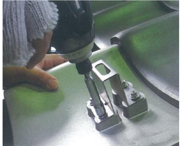
瓦形状の鋳物ベースを瓦の代わりに設置し固定金具、更に取付レールを固定する
