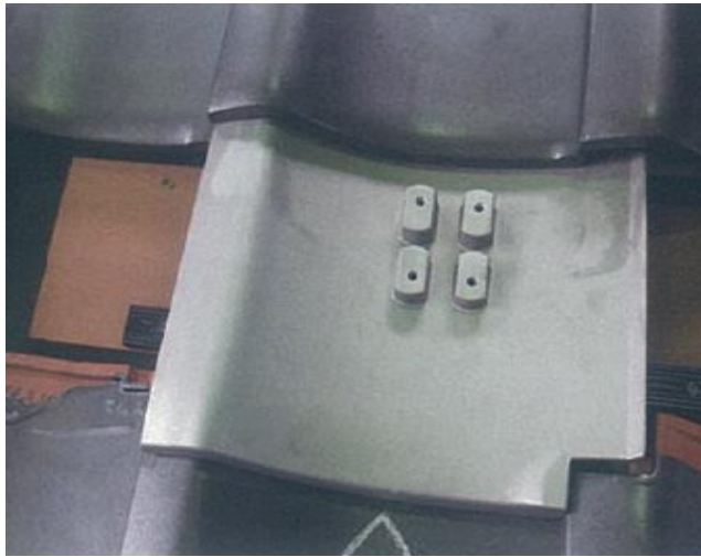
瓦形状の鋳物ベースを瓦の代わりに設置し固定金具、更に取付レールを固定する
