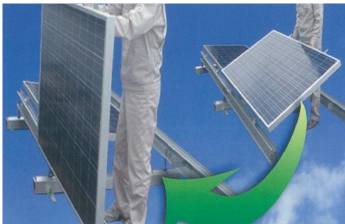
アルミ型材の利用で回転機能を持たせている
